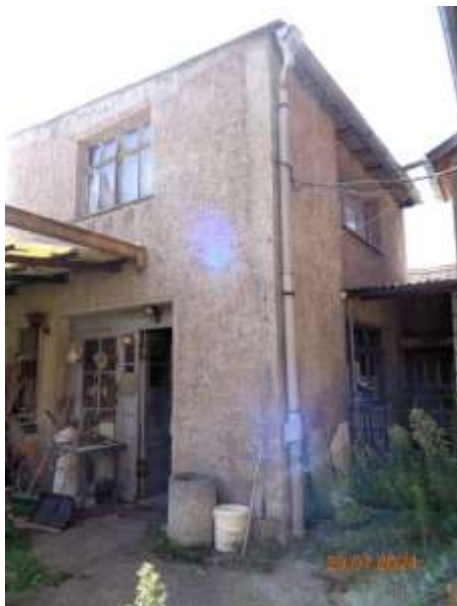
Bild 7: Werkstattgebäude im Hofbereich – Nord-Ost-Ansicht
