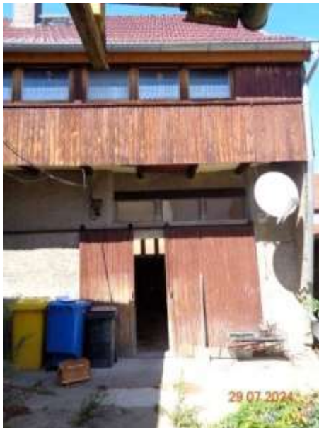
Bild 3: hofseitige Südansicht des Wohnhauses mit Laubengang im Obergeschoss
