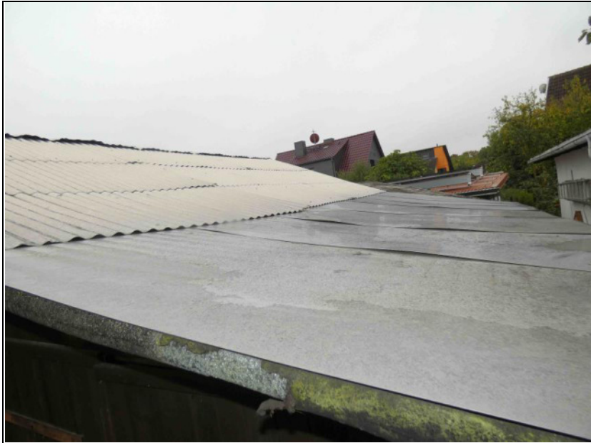
Bild 10: Dacheindeckung Bungalow und Anbau
