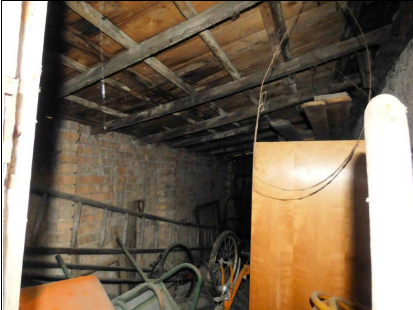
Bild 7: Anbau, Über- dachung Innen- ansicht
