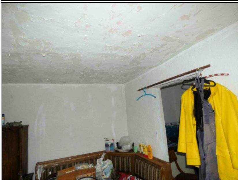
Bild 5: Zustand Bungalow innen
