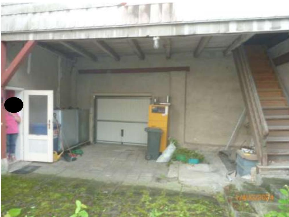
Bild 20: Metallschwinger der Hofeinfahrt von der Oberen Karlstraße unter dem Überbau; rechts die Treppe zum Überbau und Obergeschoss des Nebengebäudes
