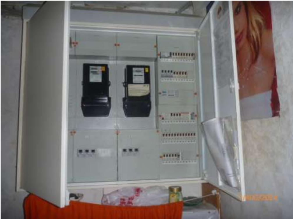
Bild 17: erneuerter Zählerschrank im Treppenhaus mit Zähler für Normal- und Nachtstrom
