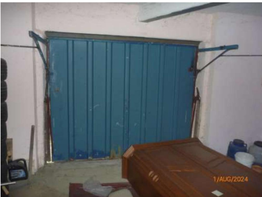
Bild 22: metallenes Garagenschwinger als Zufahrt von der Oberen Karlstraße zur Garage im Erdgeschoss des Nebengebäudes
