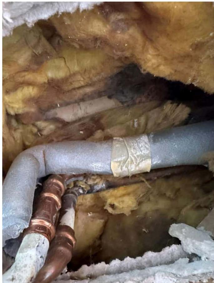
Abbildung 24 offene Rohrleitung im Spitzboden
