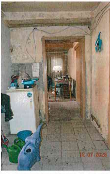
4) Erdgeschoss links im Rohbauzustand / Sanierung geplant bzw. teilweise begonnen
