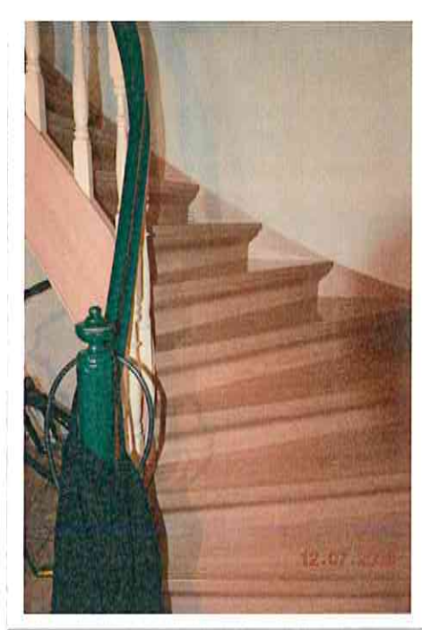
13) Geschosstreppe zum OG
