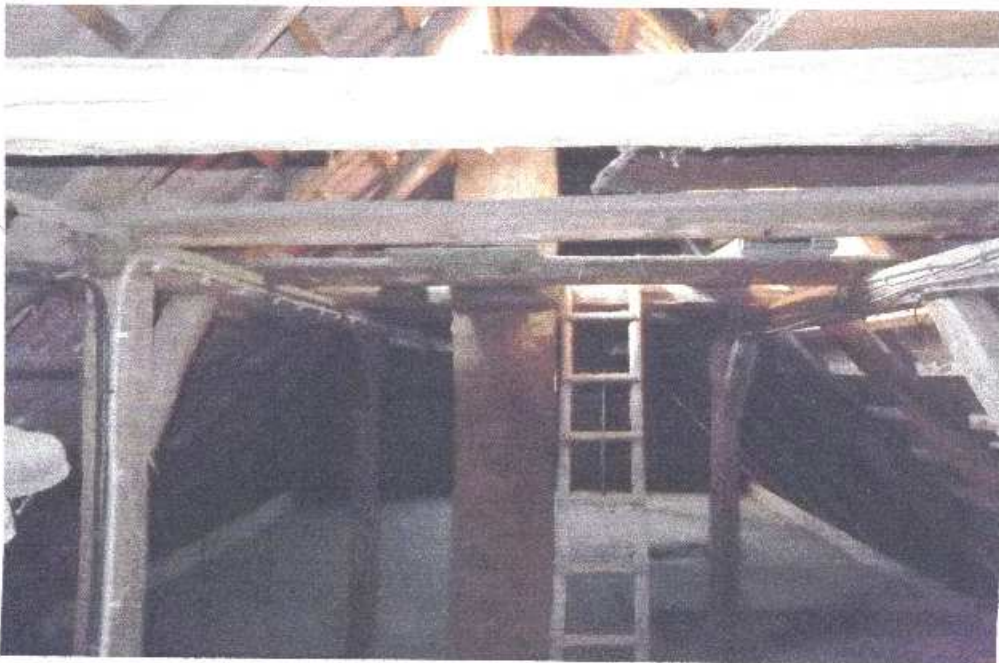
Bild 18 Wohnhaus, DG, Dachboden, Nordseite
