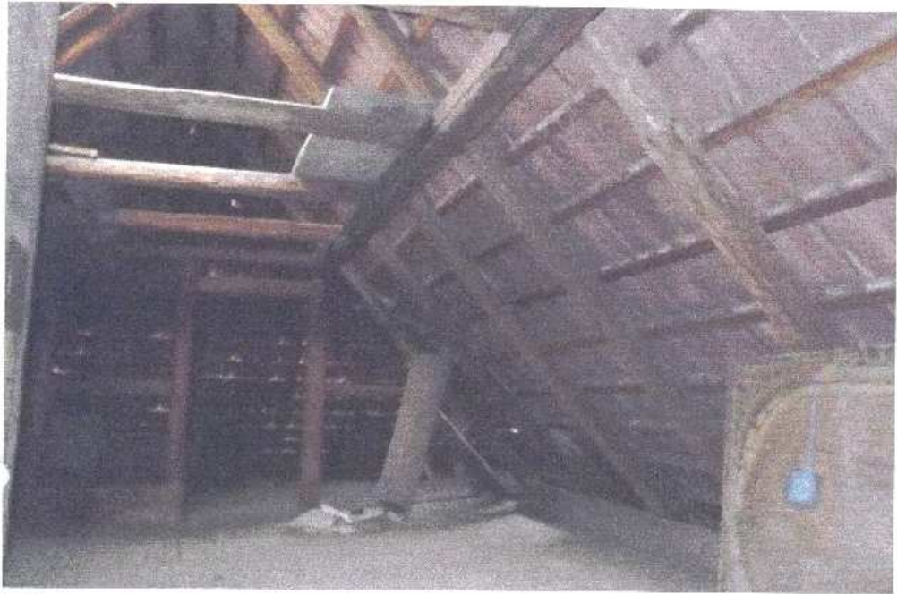
Bild 17 Wohnhaus DG, Dachboden, Südflügel
