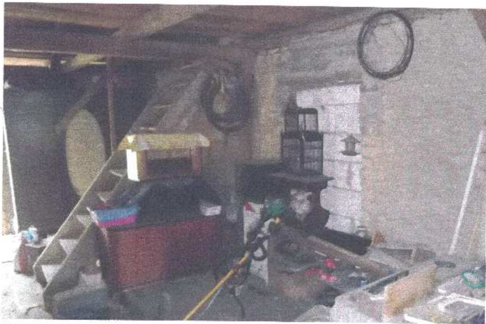
Bild 8 Scheune, OG, Treppe zum DG Stall und Wohnhaus
