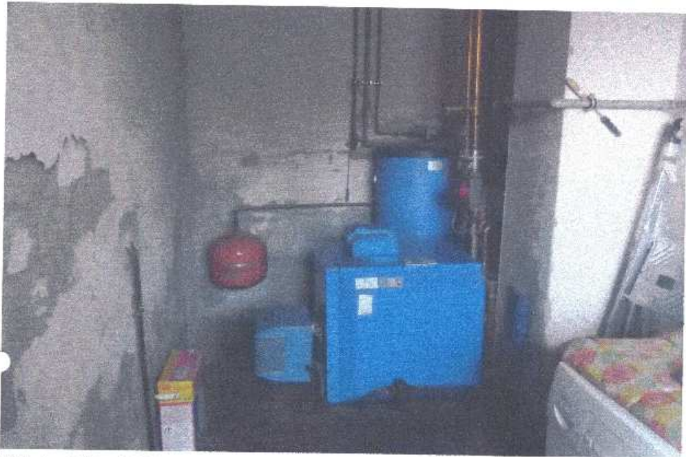
Bild 7 ehem. Stallgebäude, EG, Heizung
