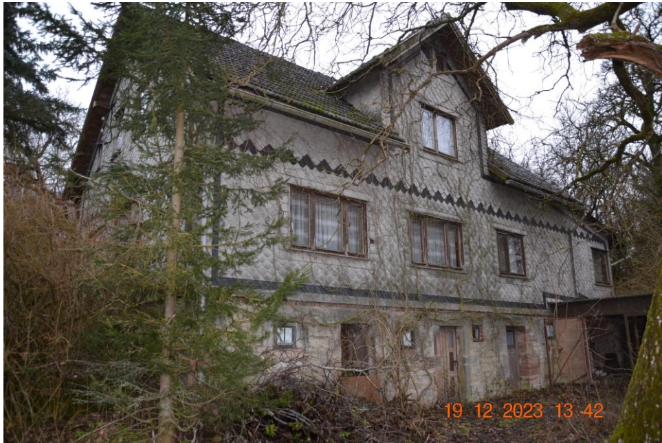
Bild 3: Rückansicht aus südwestlicher Richtung
