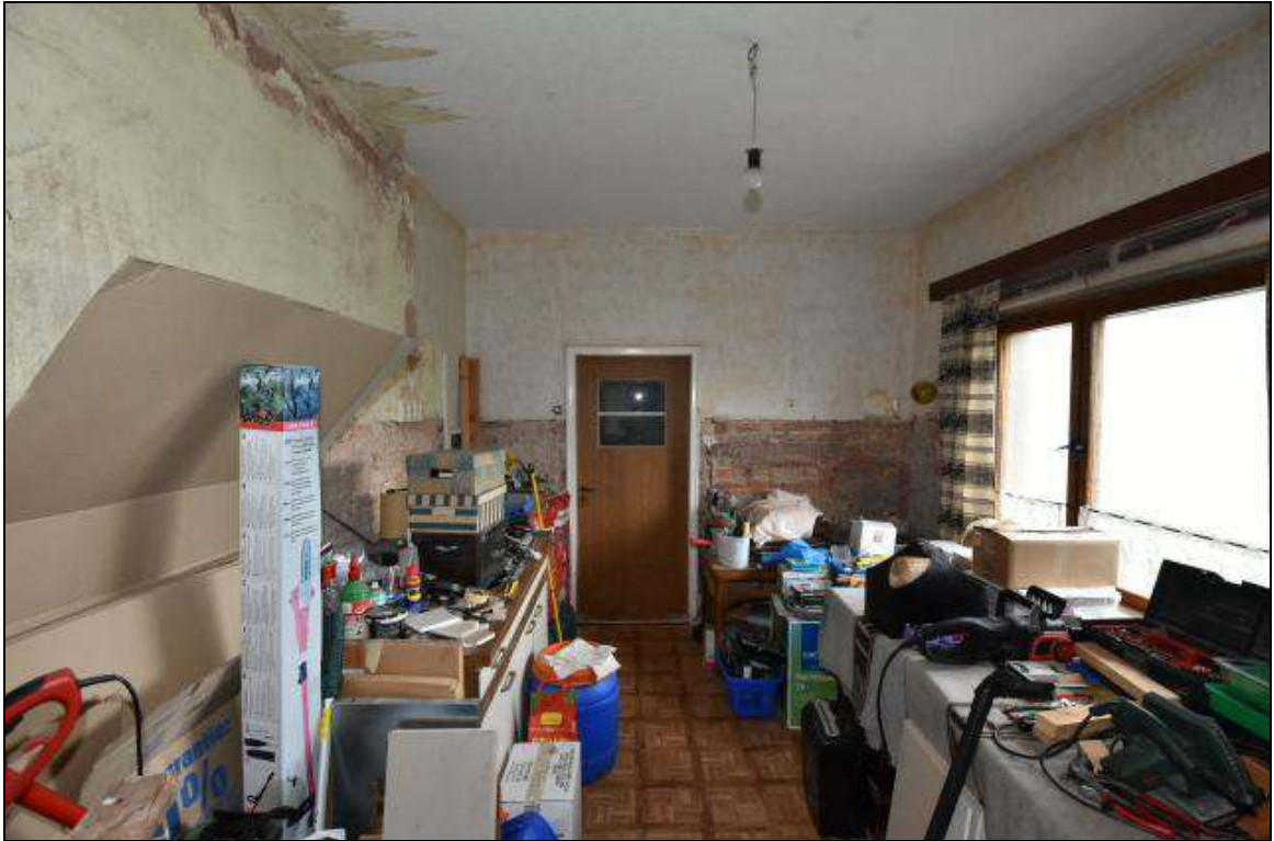
Erdgeschoss, Wohnbereich Südost, Küche mit Tür zum Treppenhaus
