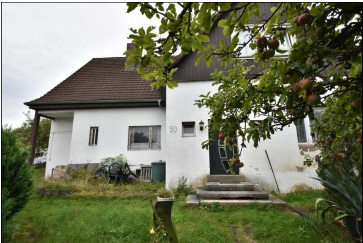
Wohnhaus mit Haustür, Nordostansicht
