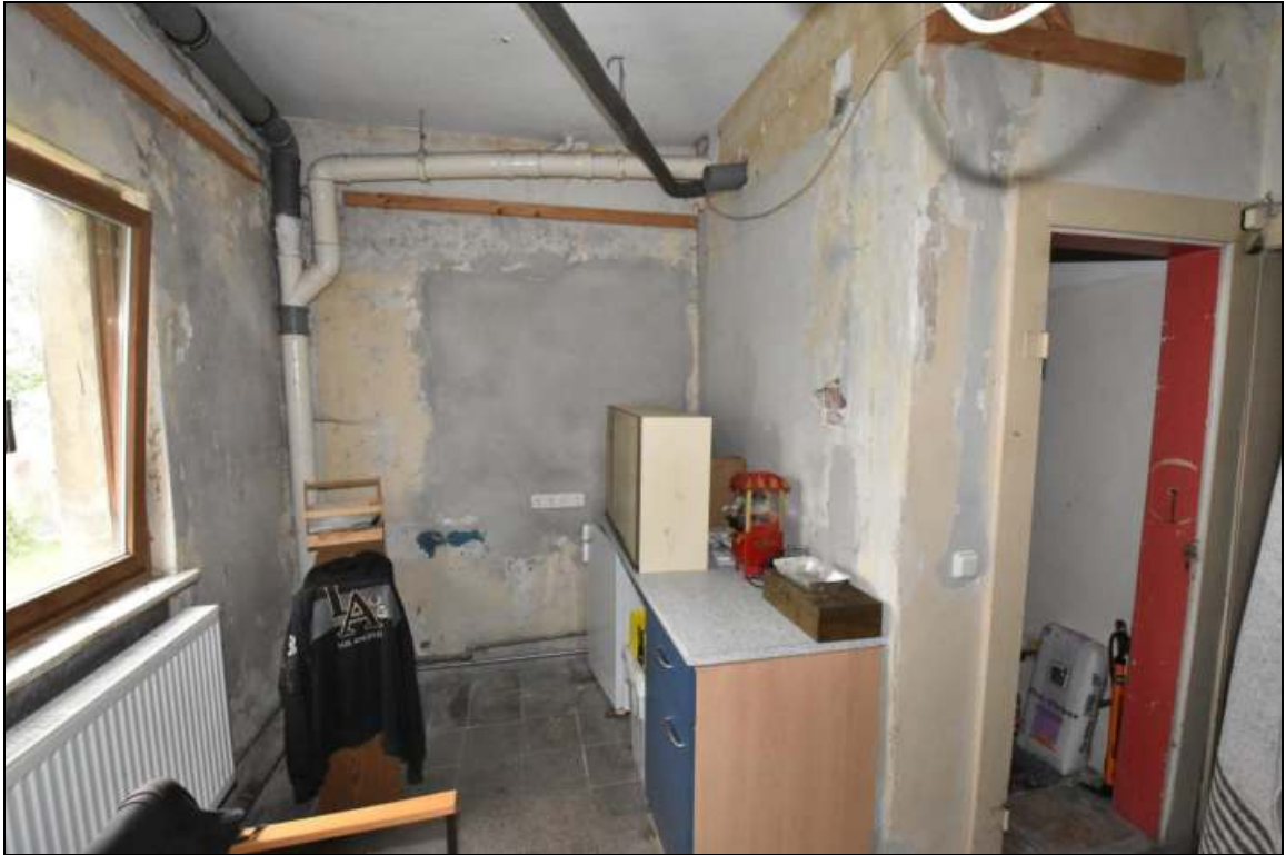
Erdgeschoss, Wohnbereich Nordwest, Küche, Sanitärbereich
