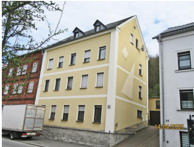
Mehrfamilienhaus in der Ansicht von der Plauenschen Straße nach Westen
