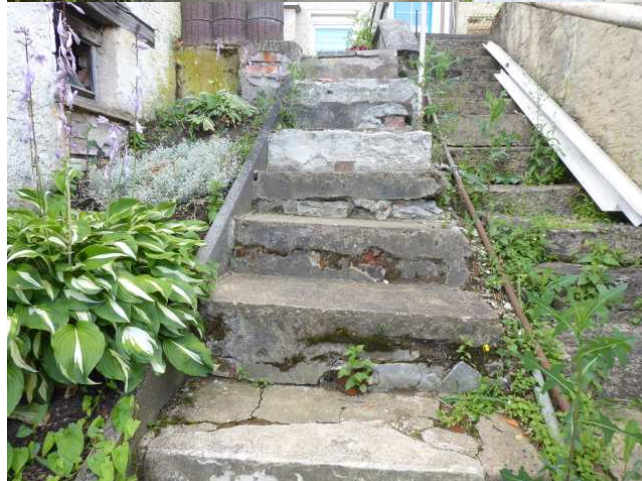
schadhafte Differenzstufen zum nördlichen Grundstücksteil Foto 8
