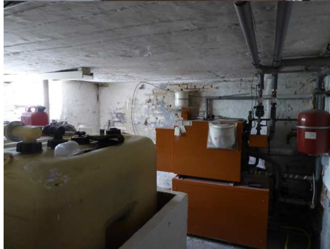
Heizungszentrale und Heizöllager im Keller Foto 6
