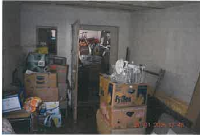
Innenansicht Nebenräume im seitlichen Anbau
