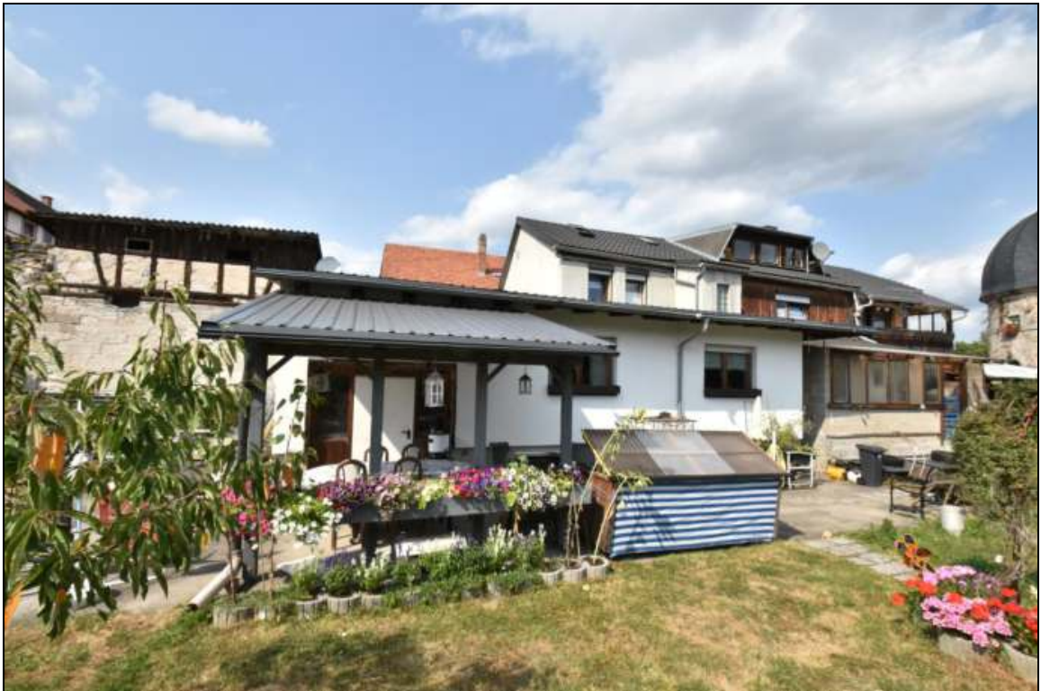
Südwestlicher Bereich mit Wohnanbau im Vordergrund Südansicht
