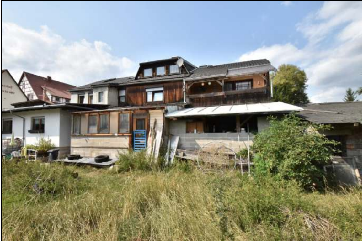
Zweifamilienhaus, Hinterseite mit eingeschossigem Wohnanbau (links) und weiteren Nebengelassanbauten sowie abzubrechendem Massivschuppen (rechts) Südostansicht
