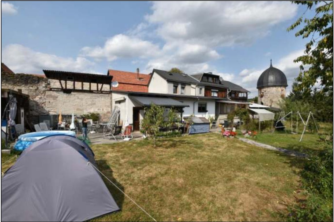
Gesamtobjekt, Hinterseite mit Garten Südansicht
