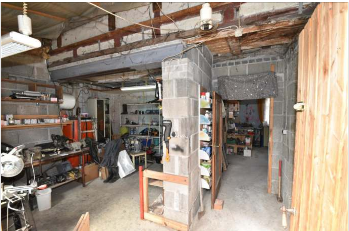
Erdgeschoss Nebenglassbereich, Werkstatt / Abstellraum
