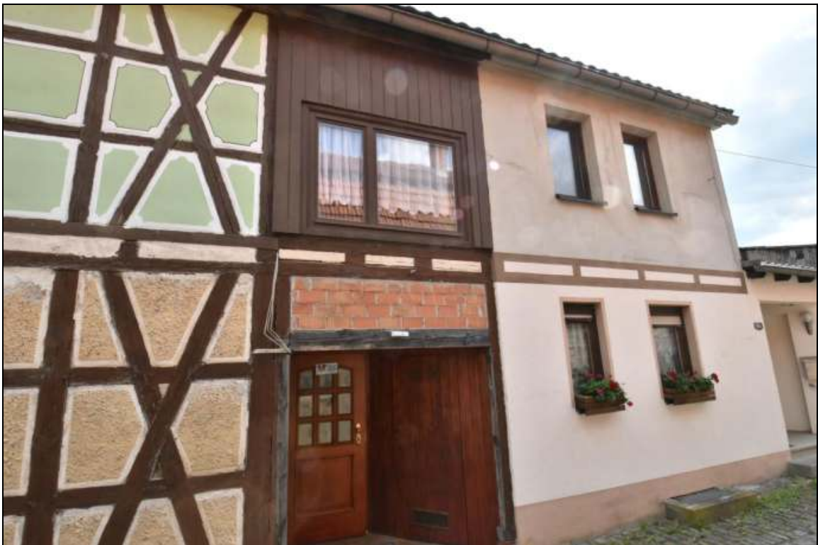
Bereich Haustür zum Treppenhaus Obergeschoss, Nordansicht mit nachfolgendem Wohnungseingang Erdgeschoss (rechts)
