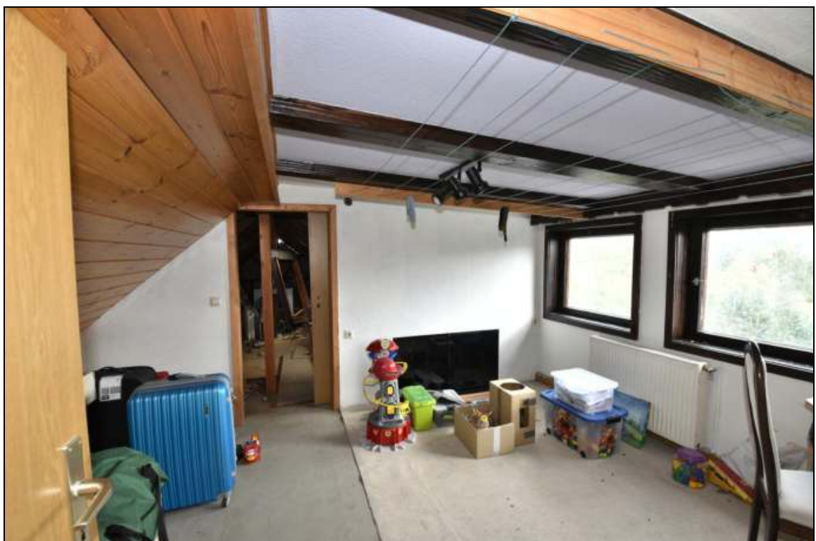
Ausgebauter Dachraum (lichte Raumhöhe < 1,90 m)
