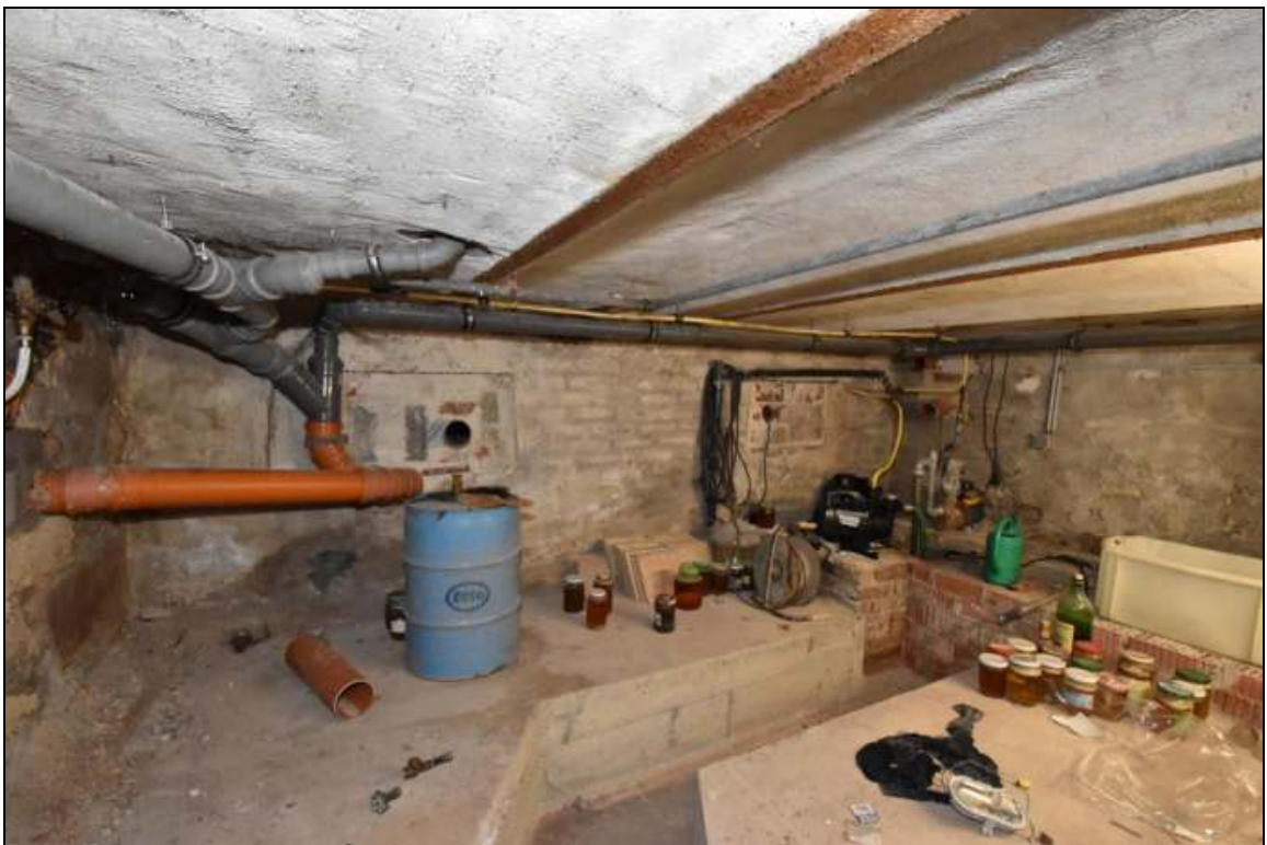
Teilunterkellerung (lichte Raumhöhe ca. 1,65 m)
