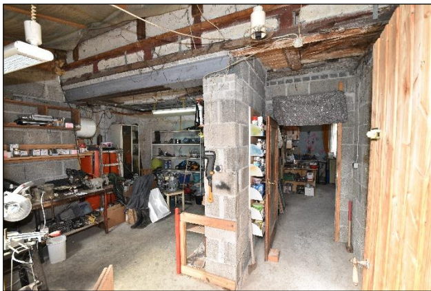
Erdgeschoss Nebenglassbereich, Werkstatt / Abstellraum
