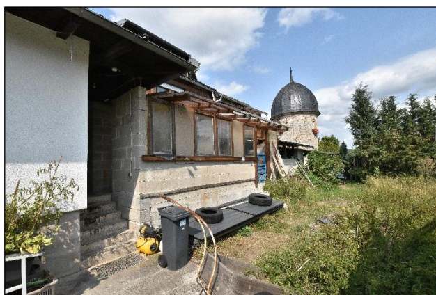
Nebengelassbereich mit Hintereingang und nachfolgendem abzubrechendem Massivschuppen, Südansicht
