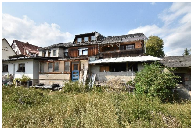
Zweifamilienhaus, Hinterseite mit eingeschossigem Wohnanbau (links) und weiteren Nebengelassanbauten sowie abzubrechendem Massivschuppen (rechts), Südostansicht
