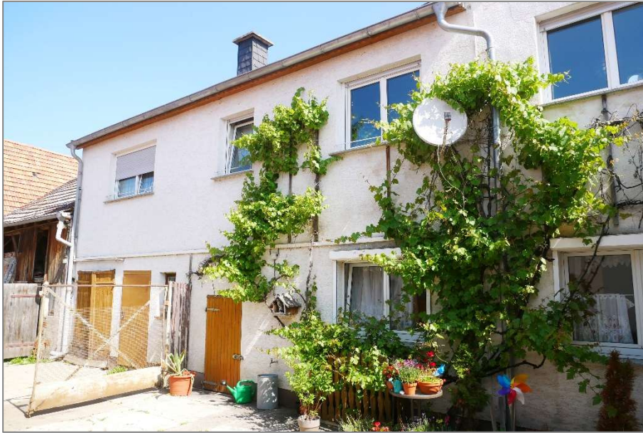
Wohnhaus / westseitiger Anbau - Südostansicht
