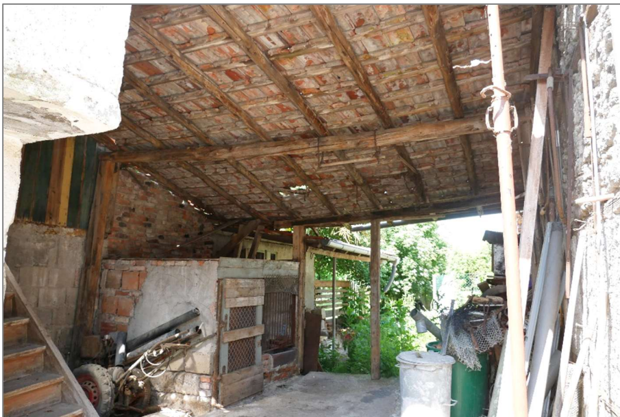
Überdachung - südlich der Scheune
