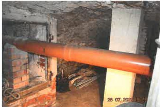
Gewölbetonne mit Abwasserrohr zum Überlauf im Hof
