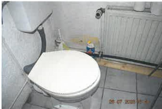
separates WC, Putzschäden im Sockelbereich
