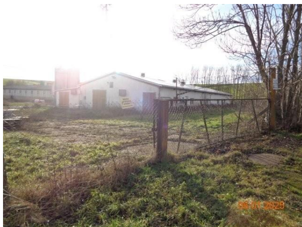
Bild 15: 1. Toreinfahrt im nördlichen Grundstücksbereich
