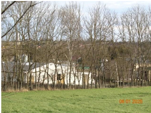
Bild 3: Gebäude 1 – Ansicht Westgiebel
