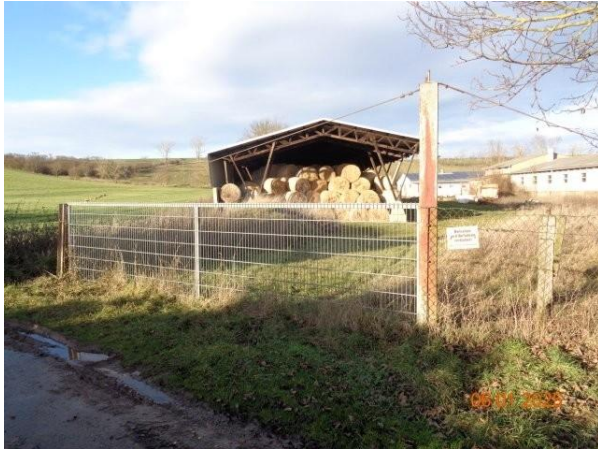
Bild 21: 3. Toreinfahrt im südwestlichen Grundstückseckbereich; südlich des Gebäude Nr. 4
