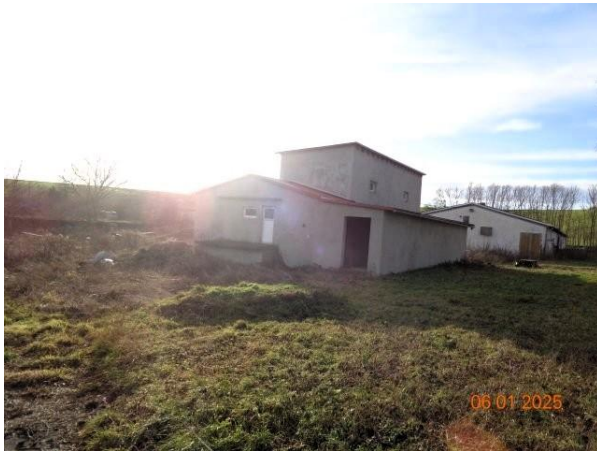
Bild 1: Bebautes Landwirtschaftsgrundstück, An der Oßmannstedter Straße in 99510 Ilmtal-Weinstraße, Ortsteil Niederroßla; Blick auf die Gebäude 1 und 2 aus nordöstlicher Richtung
