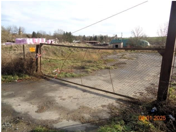
Bild 17: 2. Toreinfahrt im nördlichen Grundstücksbereich
