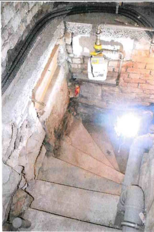
Treppe zur Teilunterkellerung
