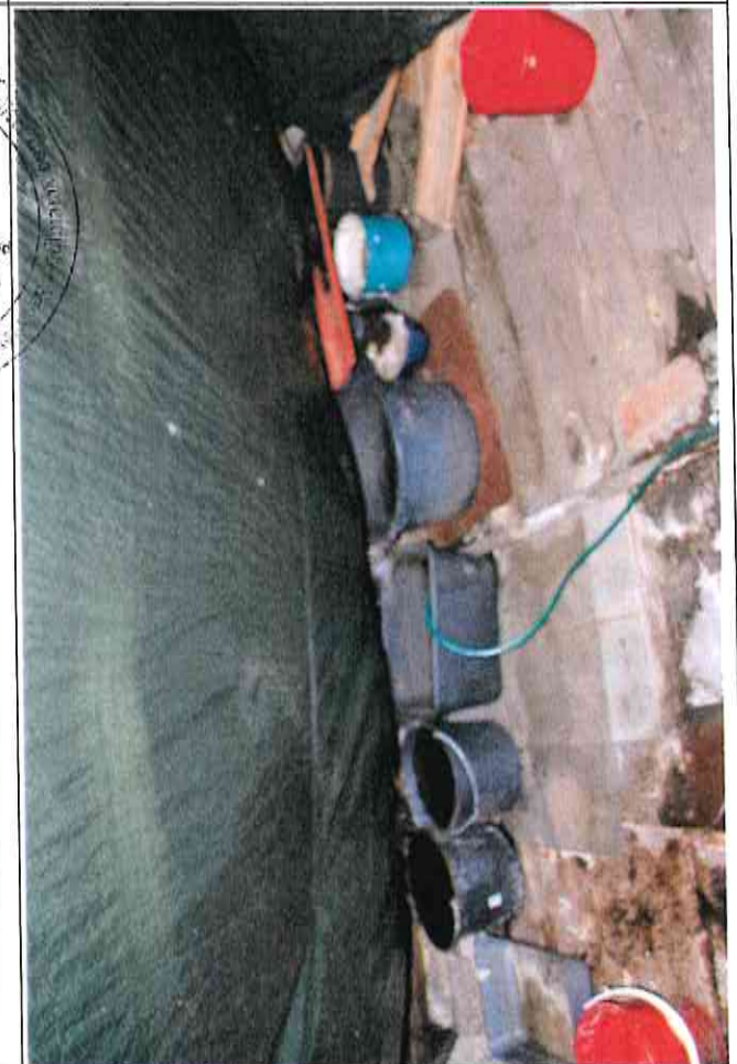
Feuchteschaden Dachgeschoss
