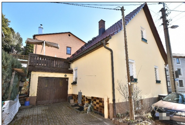
Grundstückswestansicht mit Garagenanbau und Zufahrt sowie Garagendachterrasse
