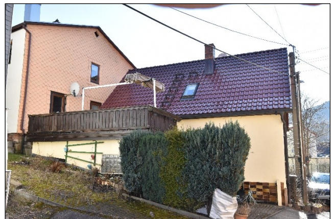
Nordwestansicht mit überbauendem Garagenanbau (links), im Vordergrund Fläche der Wegerechtsvereinbarung für Flurstück 3780
