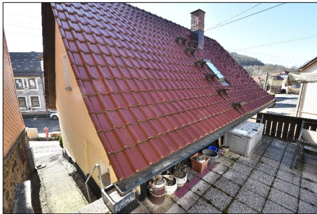
Nordansicht mit Terrassenausbildung auf Garagendach, im Vordergrund Überbau auf Flurstück 3780 und gewährter Außentreppenzugang auf Flurstück 3780 (links)
