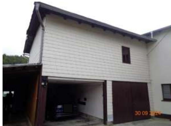
Bild 4: Hofansicht des Garagen- und Scheunengebäudes (mit Asbestschindelverkleidung)
