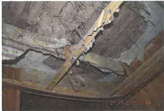
schadhafte Decke im Vorraum Keller
