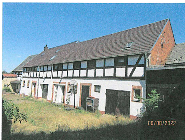
hofseitige Ansicht von ehemaliger Stallung / Remise nach Südwesten mit ausgebauter Wohnung im Obergeschoss
