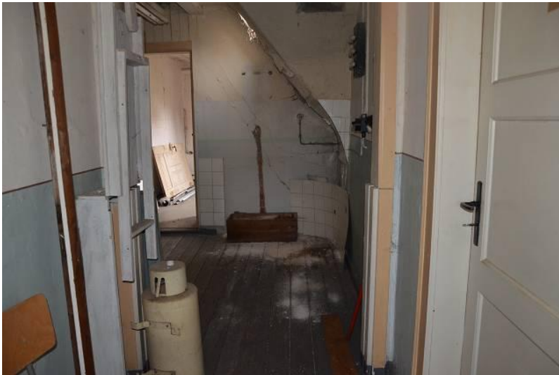
Foto 22 BEREICH IM DACHGESCHOSS
