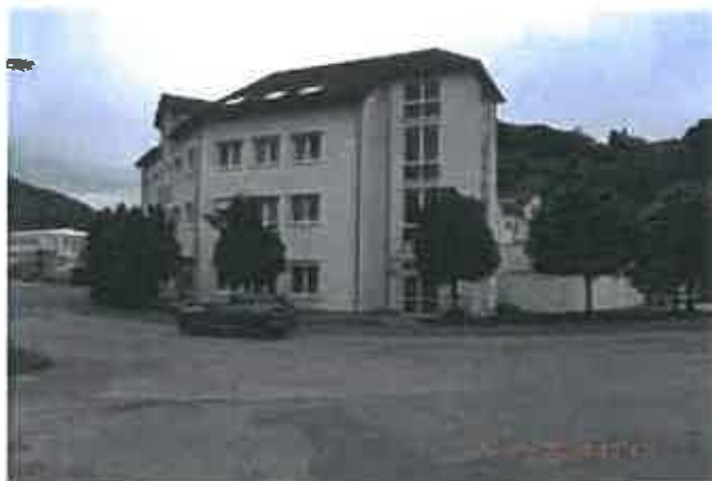
seitliche Ansicht Gebäudekomplex
