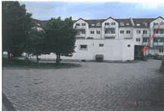
rückwärtige Ansicht eingeschossiger Anbau mit Rampe Teileigentumseinheit SM
