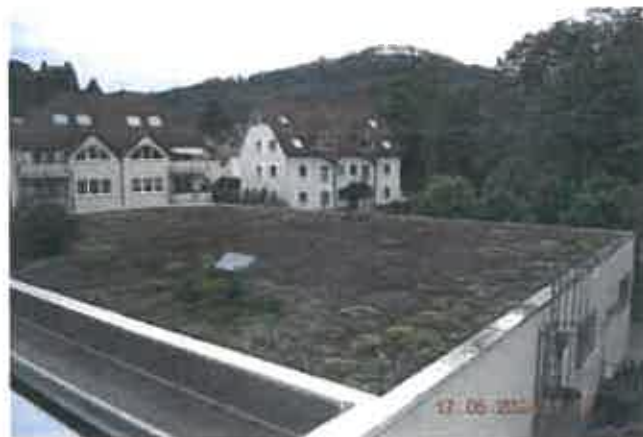
begrünter Dachbereich Anbau Teileigentumseinheit SM
