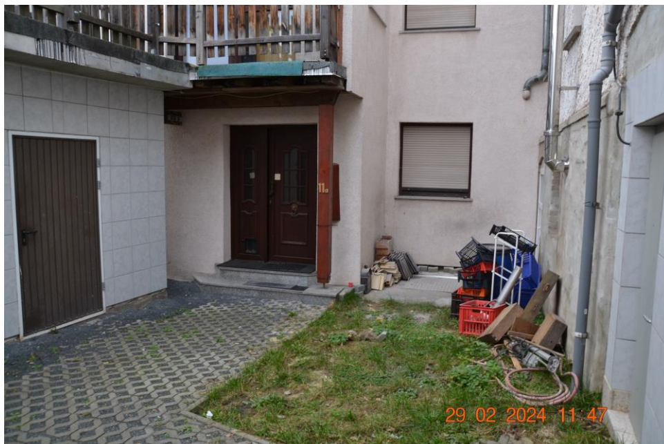
Bild 2: Zugang zum hinteren Gebäude (Bewertungsobjekt)
