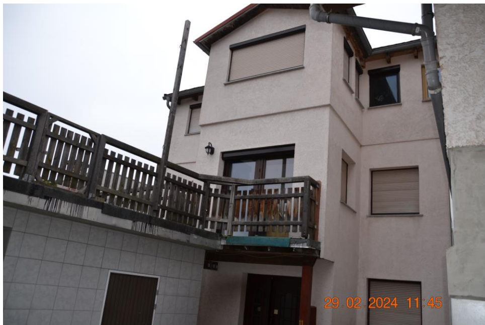
Bild 4: Ansicht des zu bewertenden Miteigentumsanteils aus östlicher Richtung
