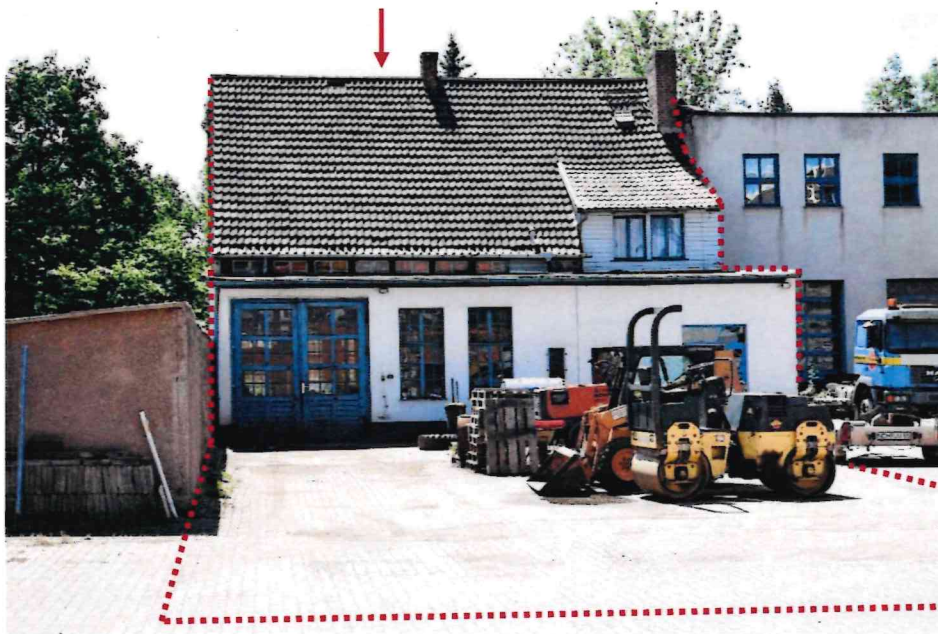
Foto 2 Nordostansicht des Bewertungsobjekts
