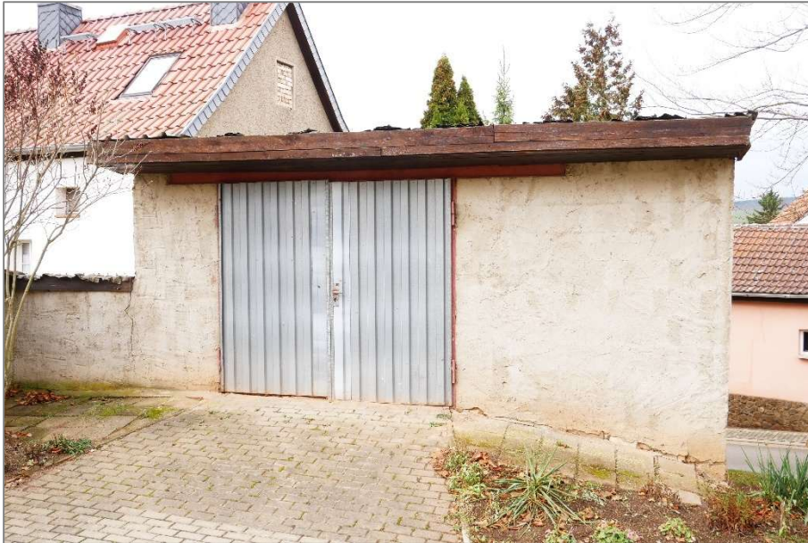
Nebengebäude / Garage - Ostansicht
