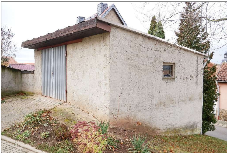
Nebengebäude / Garage - Nordostansicht
