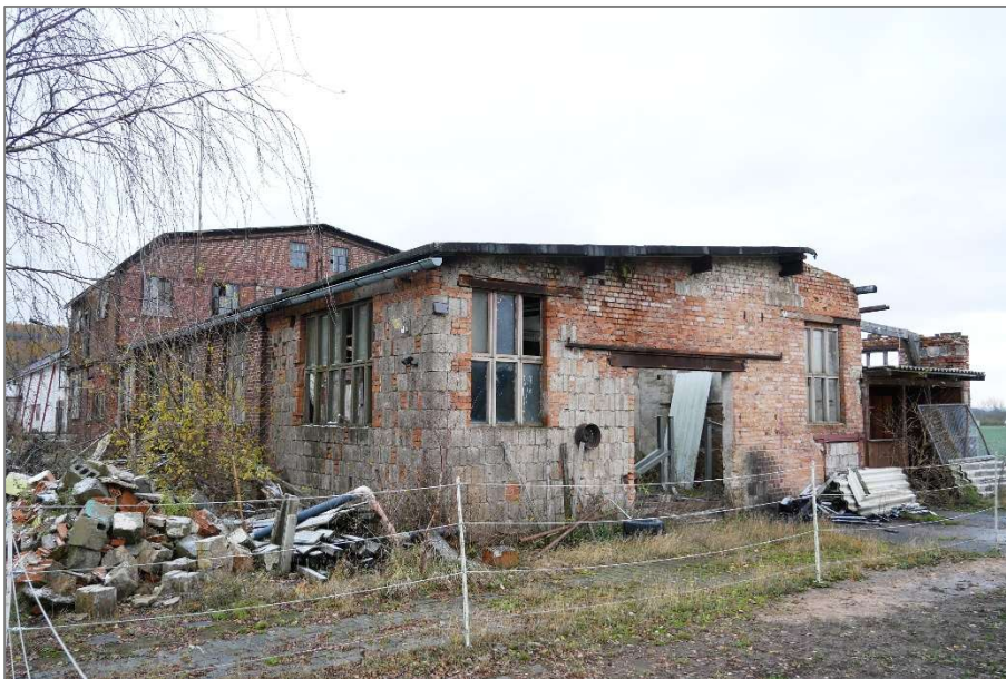
Maschinenhalle - südlicher Teil - Südwestansicht
