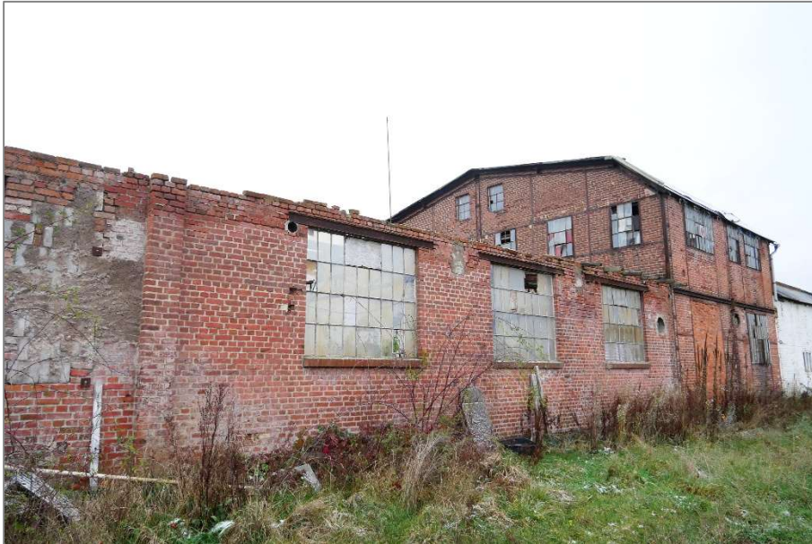
Maschinenhalle - südlicher und mittlerer Teil - Südansicht
