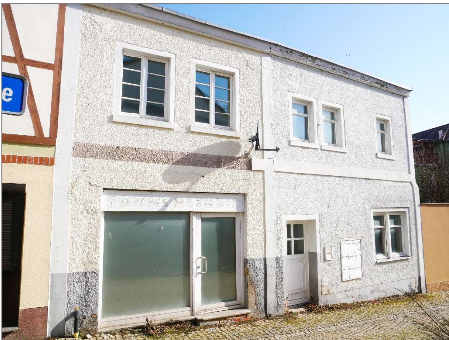
Wohn-/Geschäftshaus / Hinterhaus - Westansicht
