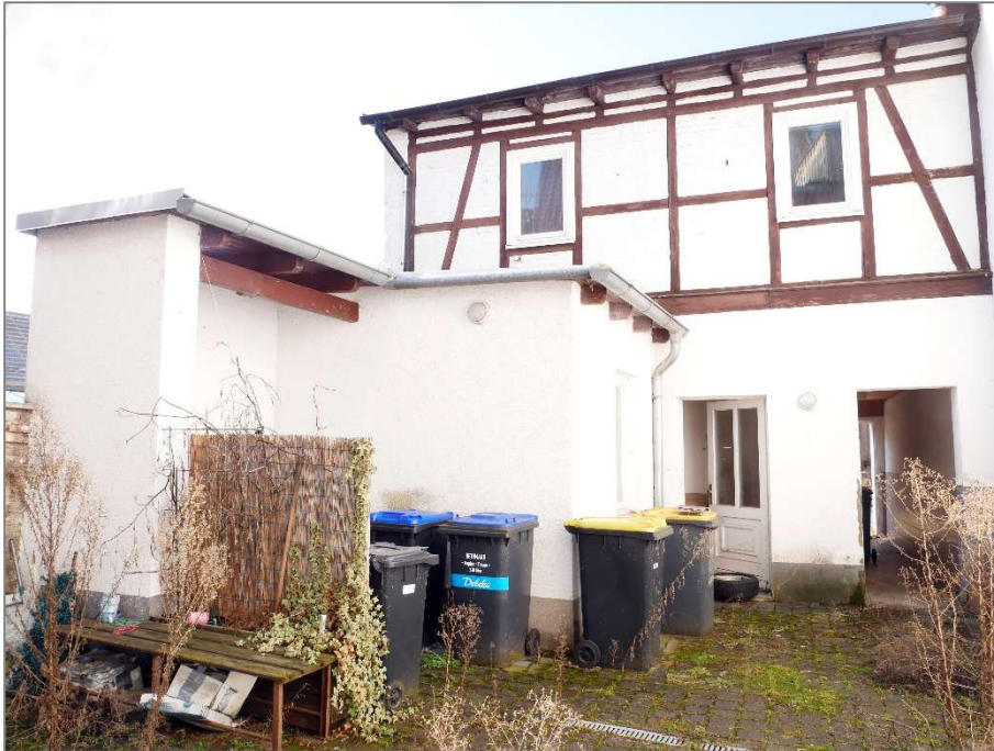
Wohn-/Geschäftshaus / Hinterhaus - Hofansicht
