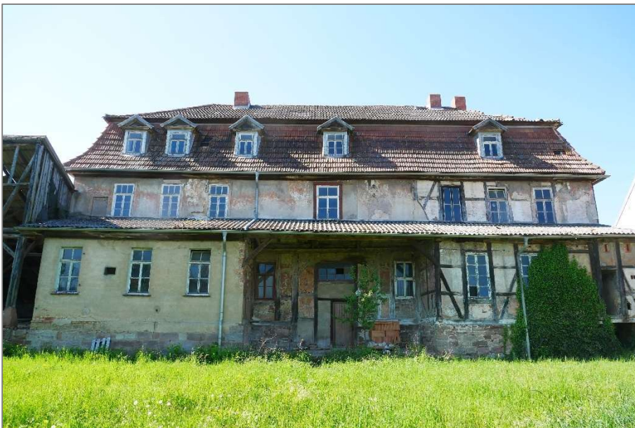
ehem. Forsthaus - Nordansicht
