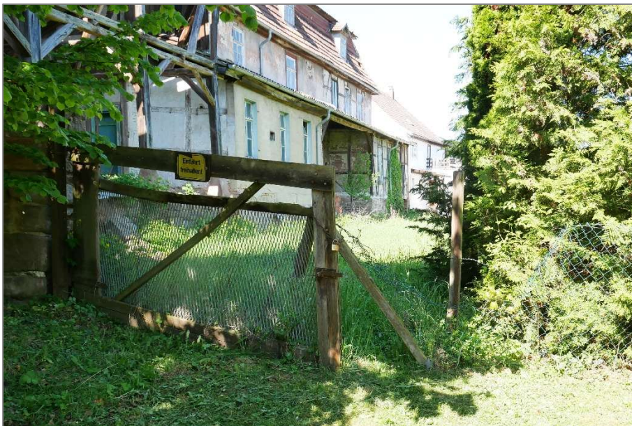
ostseitige Grundstückszufahrt von der Mühlestraße
