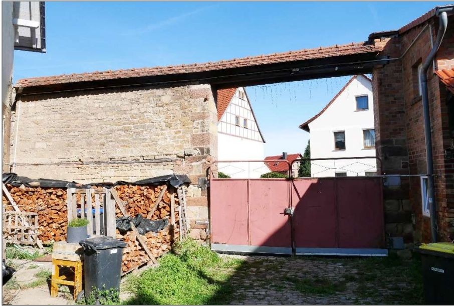
straßenseitige Einfriedungsmauer mit Torfahrt
