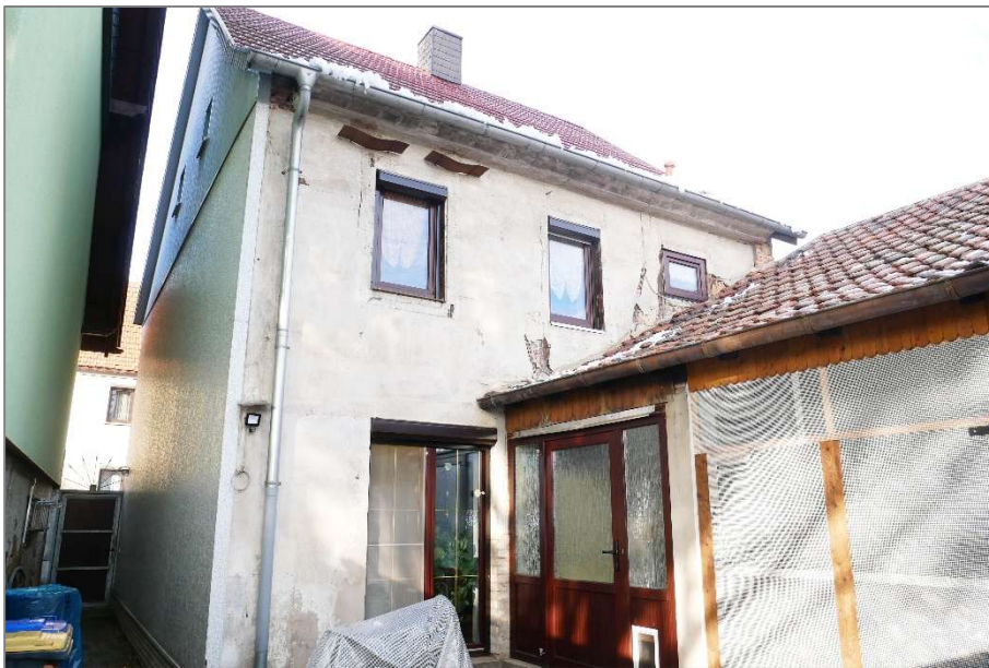
Wohnhaus - Hofansicht (Südostansicht)
