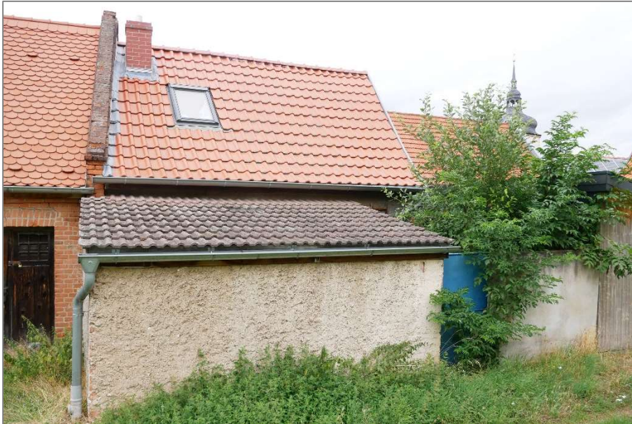
Wohnhaus mit südseitiger Überdachung / Schuppen - Südansicht
