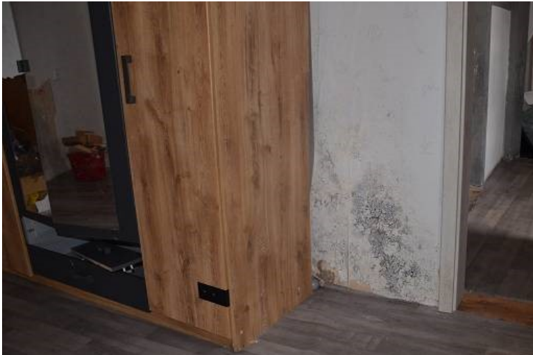
FOTO 7 RAUM IM OBERGESCHOSS UND FLUR
