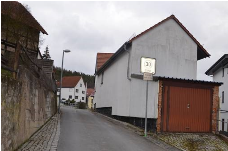
FOTO 2 NORD- WEST- ANSICHT MIT BLICK AUF DIE GARAGENER- WEITERUNG
