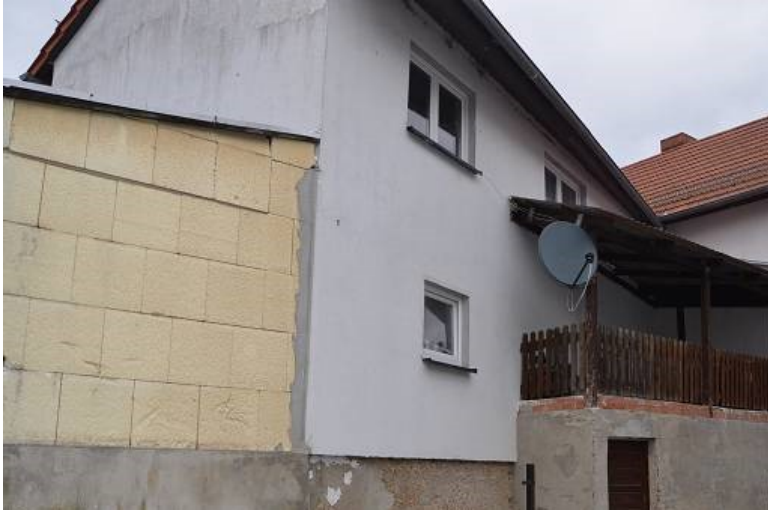
FOTO 1 SÜDANSICHT ANSICHT VOM STRAßENRAUM MIT VORGEBAUTEM NEBENGELASS UND ÜBERDACHEM BALKON
