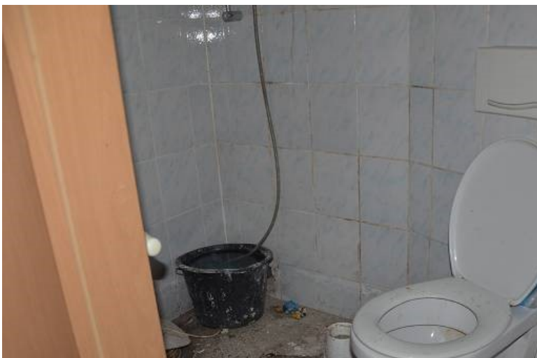
FOTO 12 WC/ DUSCHE IM ERDGESCHOSS
