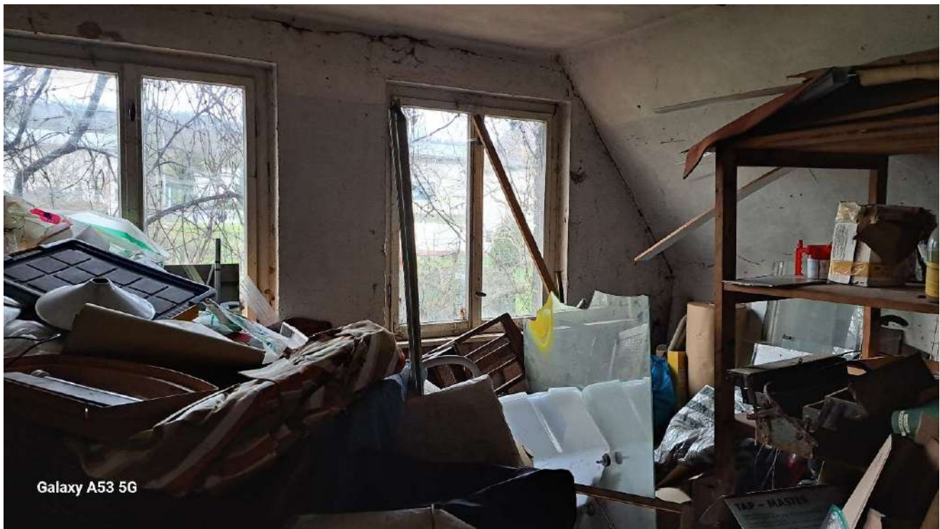
Bild 13: Gebäudeinnenansicht Nebengebäude, exemplarisch
