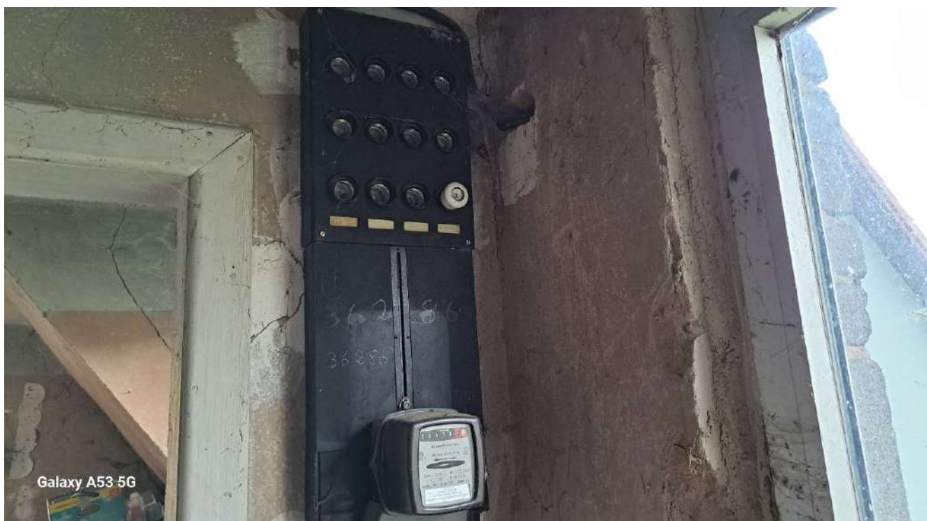
Bild 14: Gebäudeinnenansicht Nebengebäude, exemplarisch
