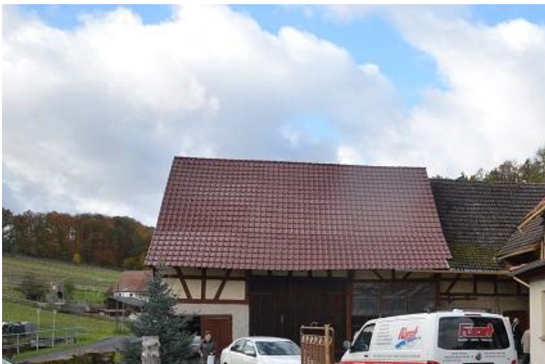
Foto 15 BLICK AUF DAS NEBENGELASS - SCHEUNE
