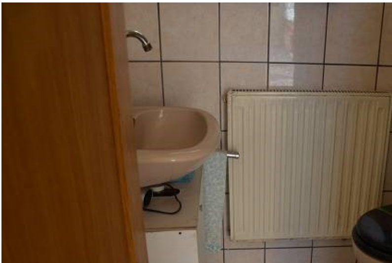
Foto 14 WC IM WINDFANGBEREICH
