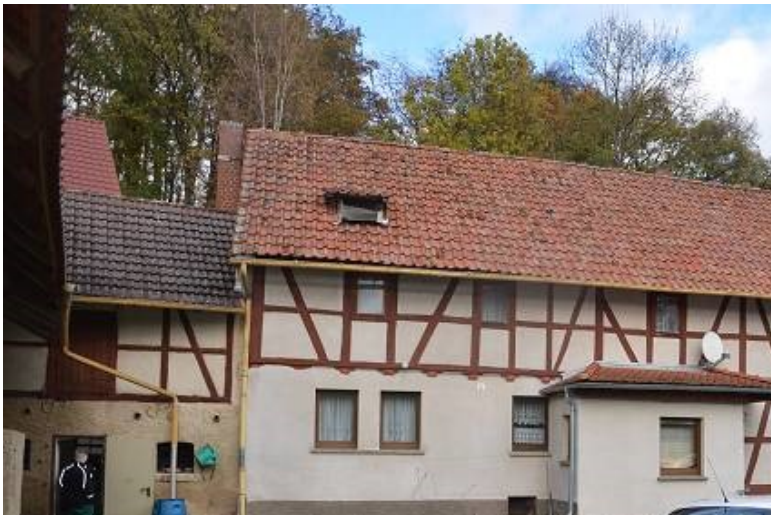
Foto 2 SÜDANSICHT MIT ANSCHLUSS NEBENGEBÄUDE
