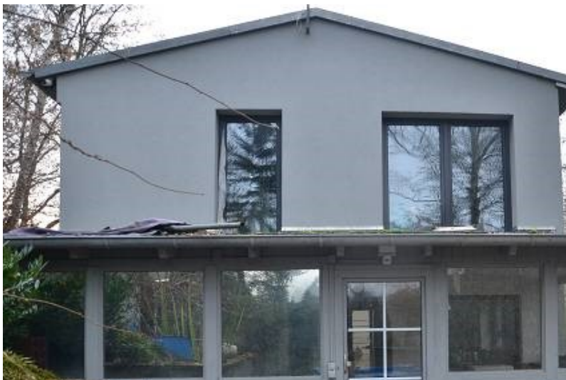
FOTO 2 OSTANSICHT MIT ANBAU IM HINTERRAUM
