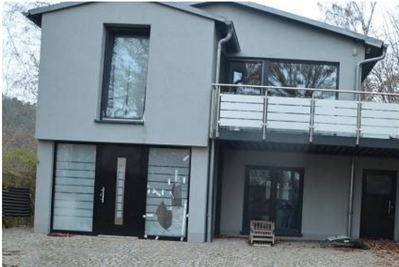
FOTO 1 FLURSTÜCK 210/ 16 WESTANSICHT MIT GRUNDSTÜCKSAUFFAHRT
