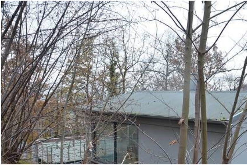
FOTO 4 BLICK AUF DAS EINFAMILIENHAUS
