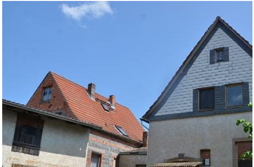
Foto 16 Wohngebäude Bernshäuser Straße 114 a Westansicht
