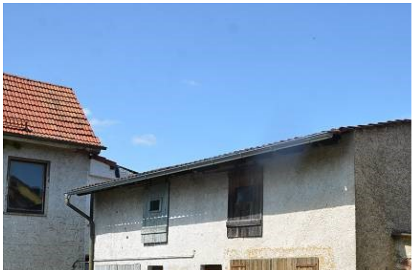
Foto 15 Garagen-/ Nebengebäude sowie kleiner Schuppen
