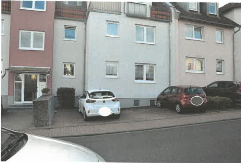
FOTOS 4-5 VORDERRAUM – STELLPLAZBEREICH (TEILBEREICH)
