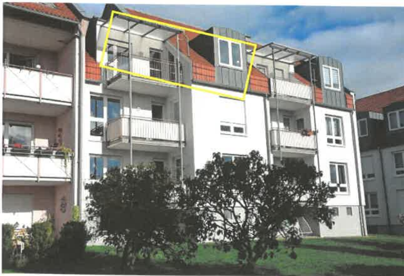
Foto 2 SÜD-ANSICHT VON HINTERRAUM
