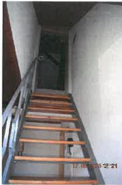
Treppe zum Dachboden
