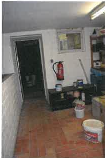
Kellerraum mit Öllager
