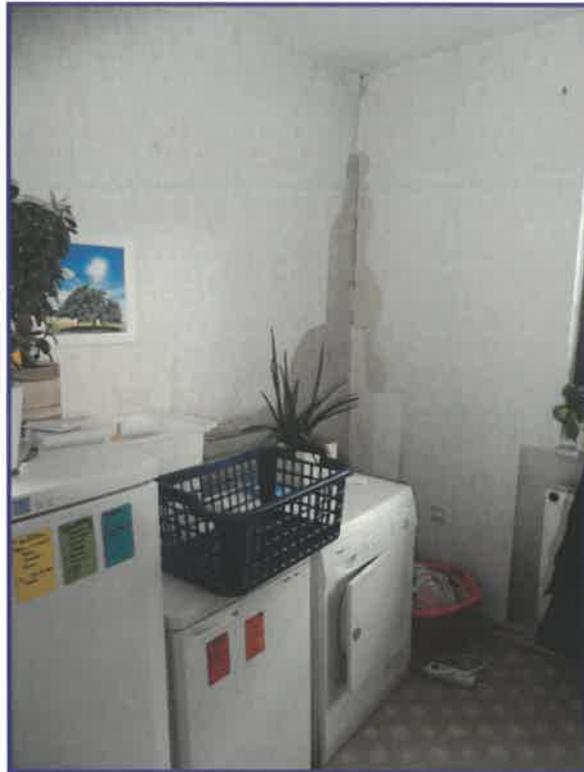
**22. Wohnbereich OG – Außenecke Oberflächen mit Feuchteschäden/ fehlende Sockelleisten**
