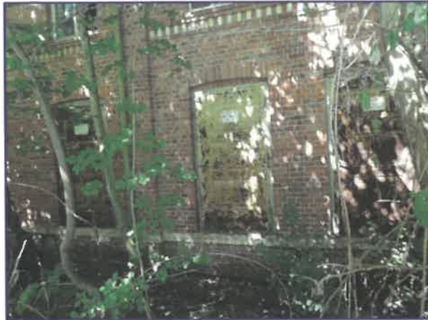
Teilansicht außen Ost
