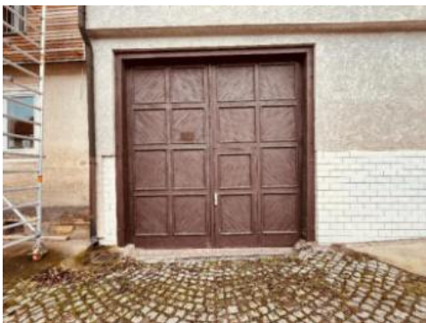
Bild 05: Detail Zufahrt Grundstück
