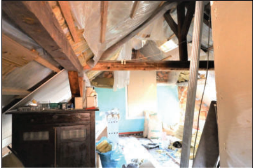
DG – im Ausbau
