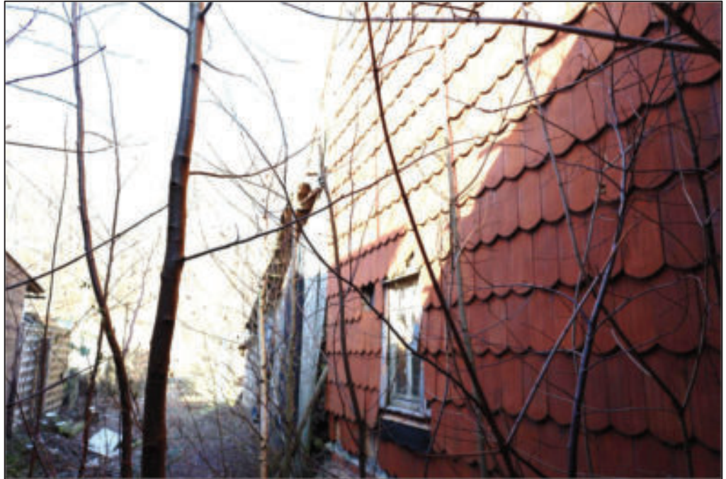
Südansicht – Nebengebäude Nr. 2
