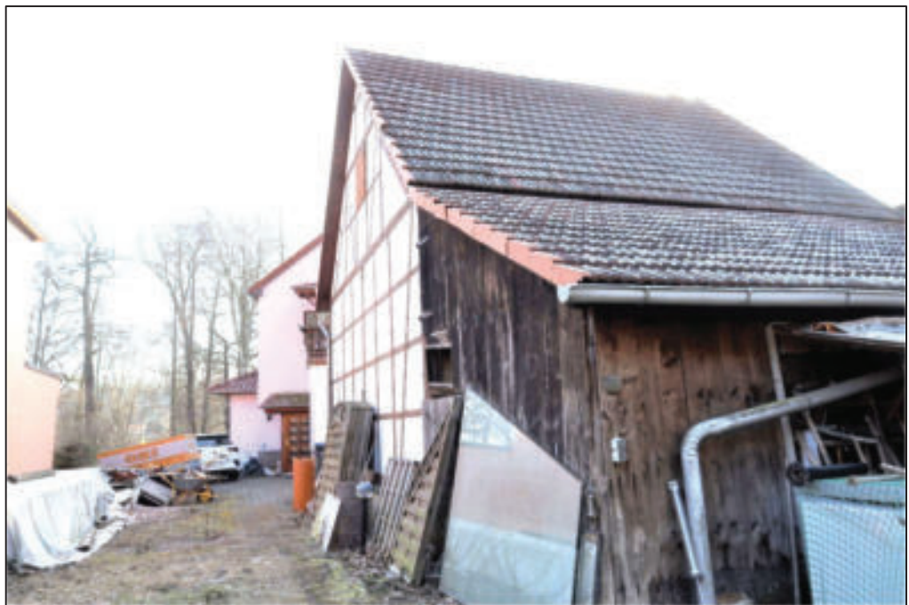
Nordansicht – Nebengebäude Nr. 2 (mit Anbau I)
