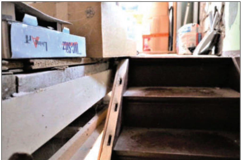
Treppe zum DG
