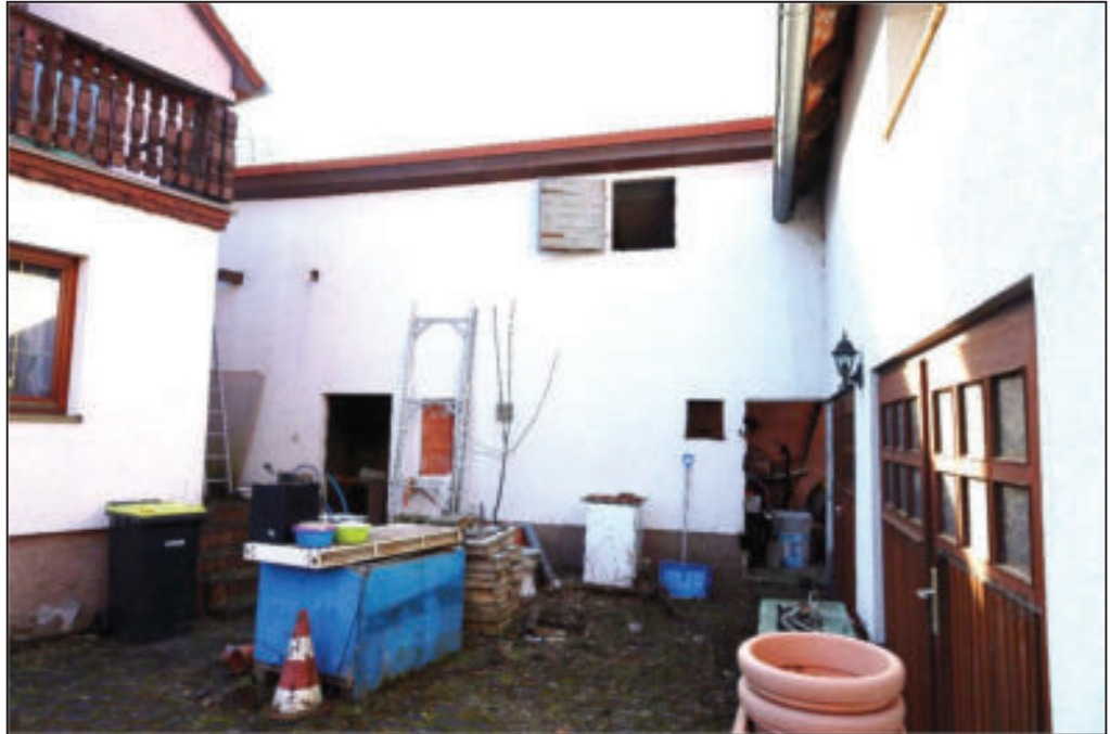
Nordostansicht – Nebengebäude Nr. 1
