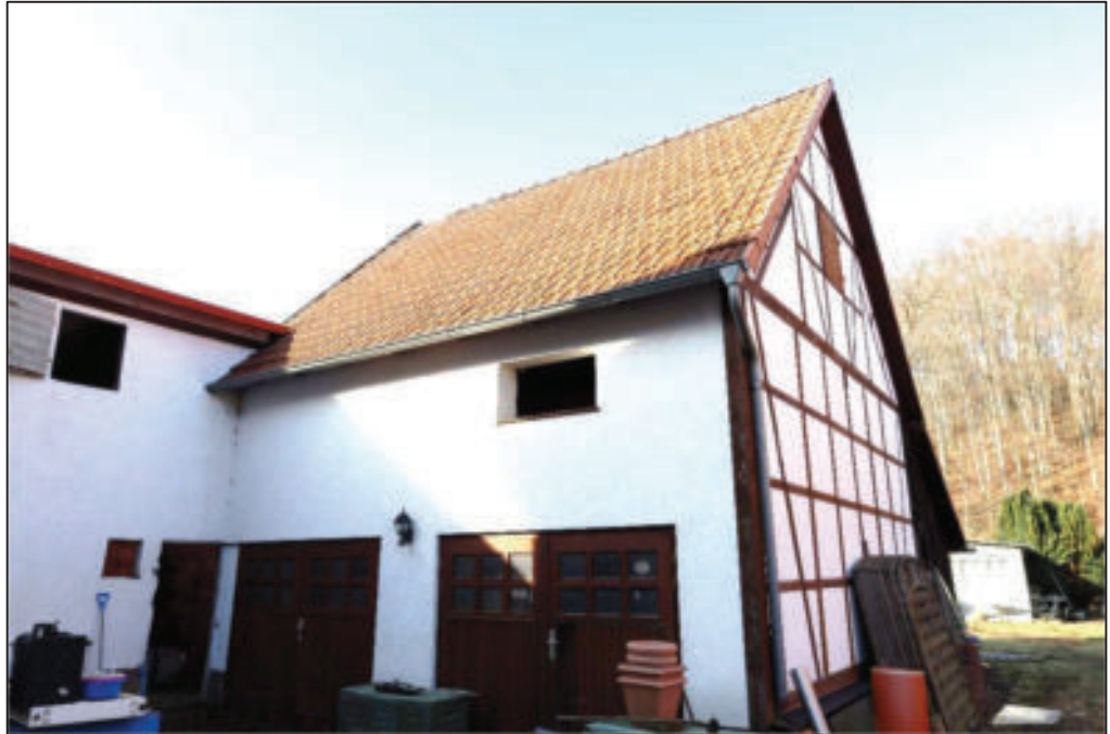
Nordostansicht – Nebengebäude Nr. 2 (mit Anbau I)
