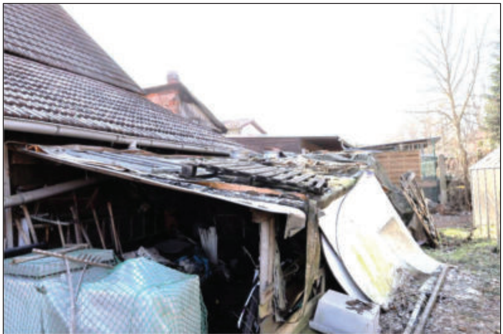
Nordansicht – Anbau II (Abriss geplant)
