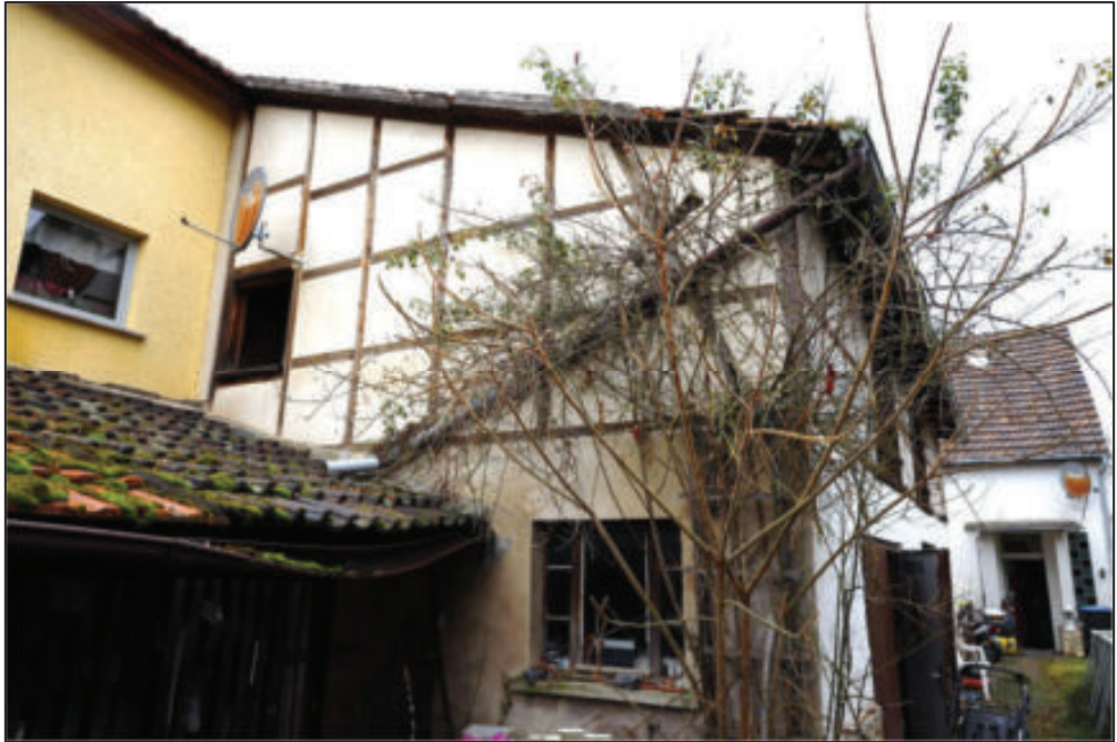
Südwestansicht – Nebengebäude mit Anbau
