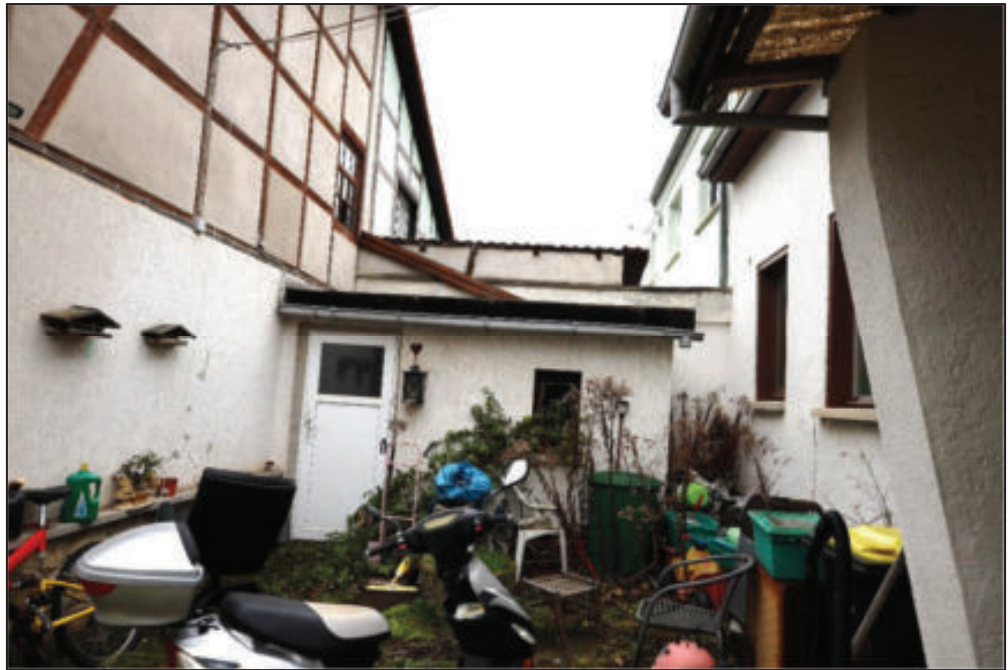
Südostansicht – Nebengebäude mit Anbau
