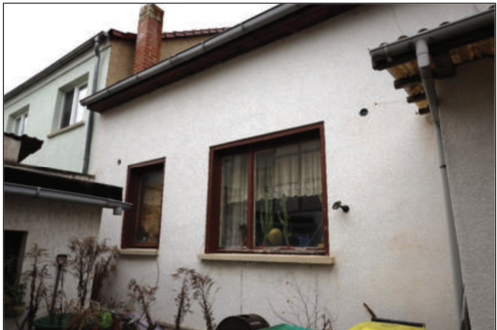
Südansicht – Einfamilienwohnhaus (DHH)
