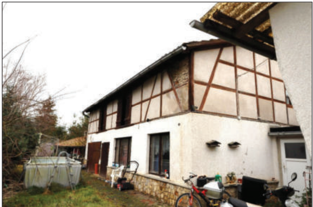
Ostansicht – Nebengebäude mit Anbau
