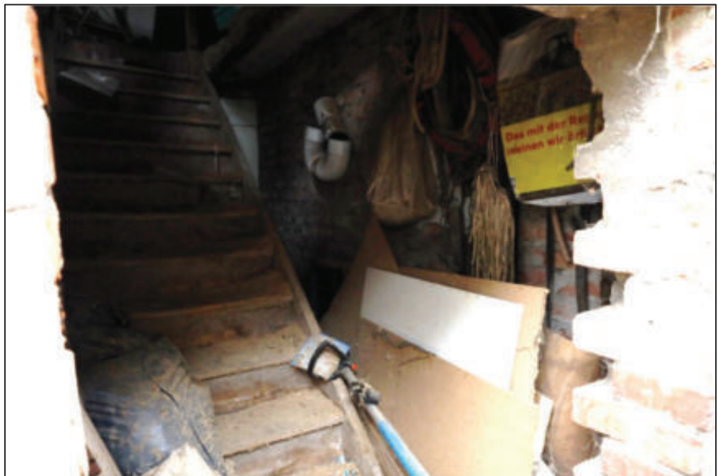
Innenansicht – Nebengebäude mit Anbau
