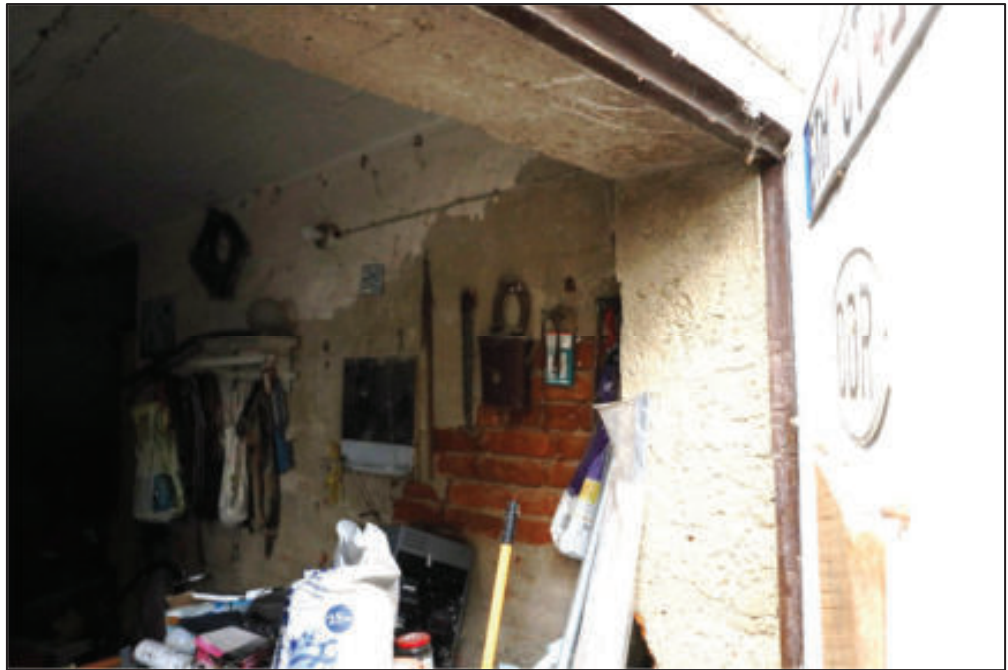
Innenansicht – Nebengebäude mit Anbau
