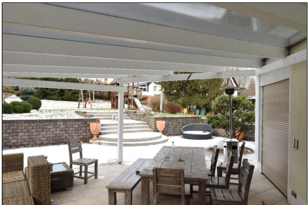
Überdachter Freisitz/ Terrasse
