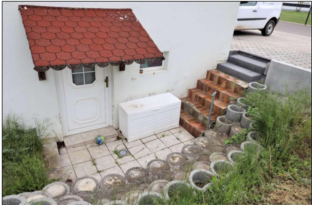
Außenansicht – Hauseingang Kellergeschoss
