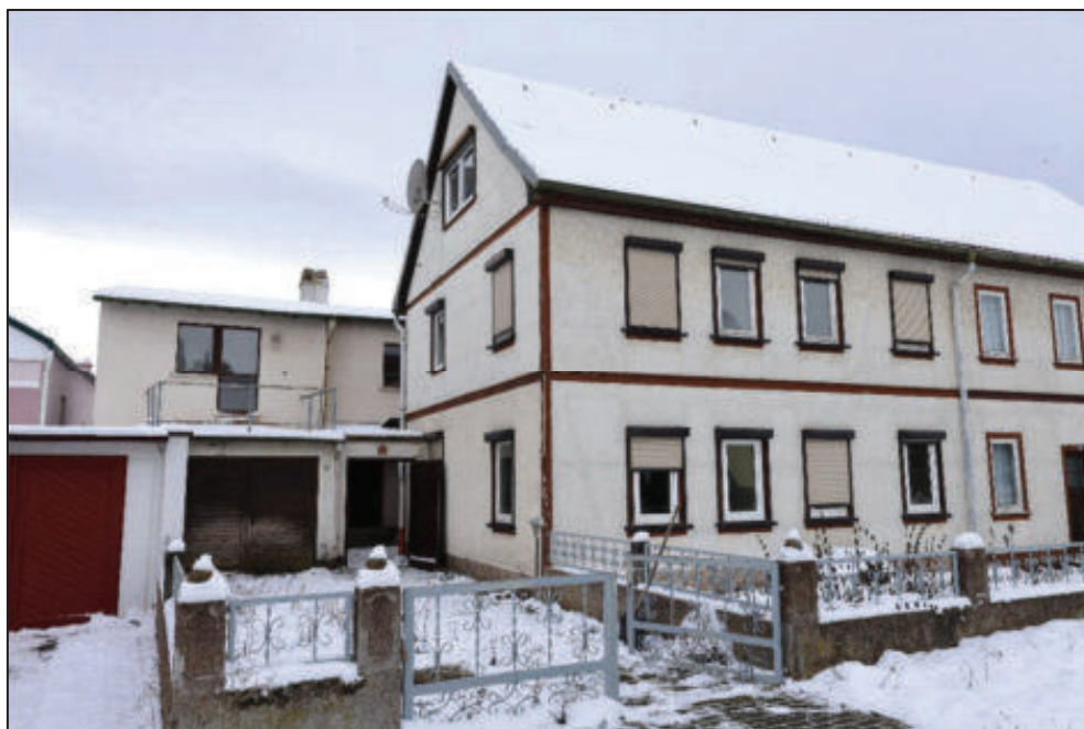
Nordostansicht / Vorder- und Hinterhaus
