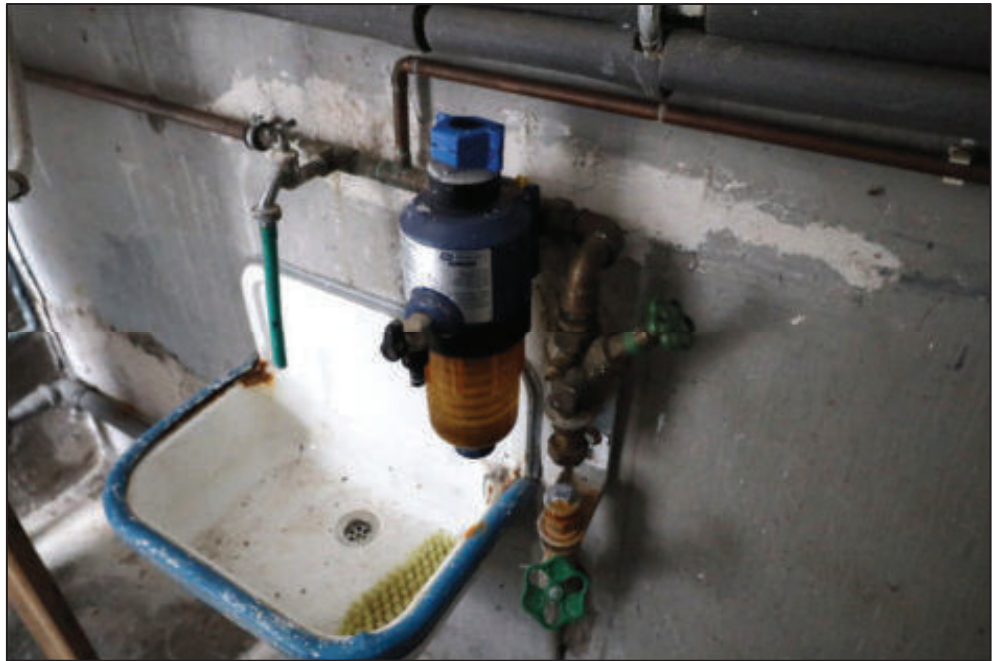
Vorderhaus – Sanitärbereich WE 1 (Anbau EG)
