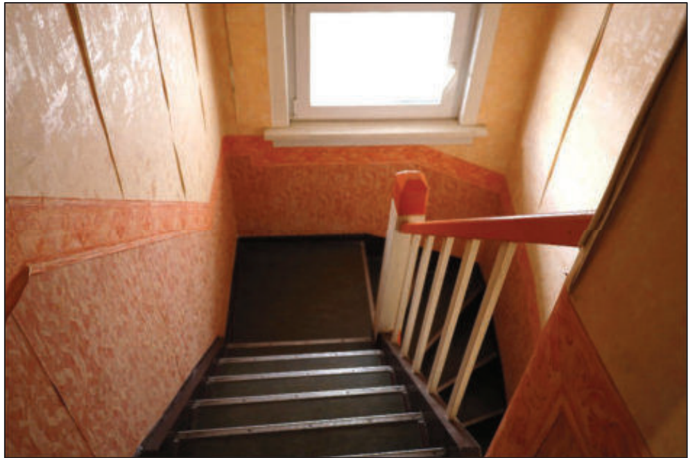
Vorderhaus – Treppe zum Dachgeschoss
