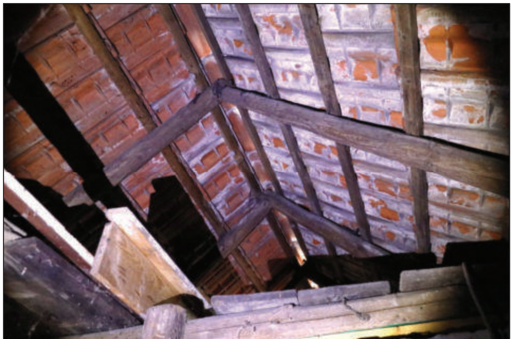
Vorderhaus – Spitzboden/ Dachstuhl
