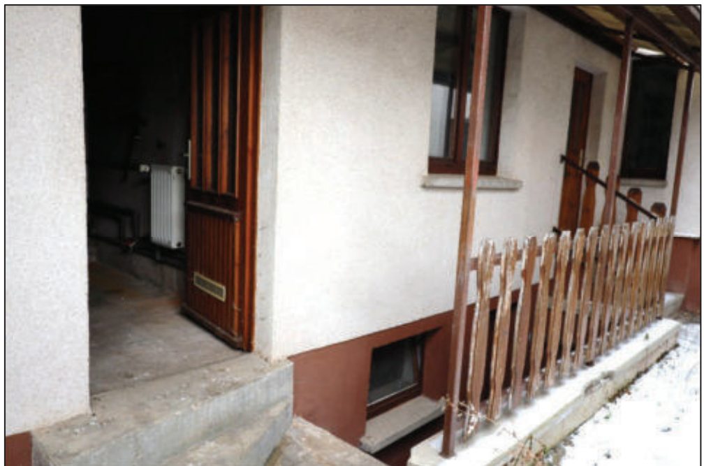
Hinterhaus – Zugang zum Heizraum u. KG
