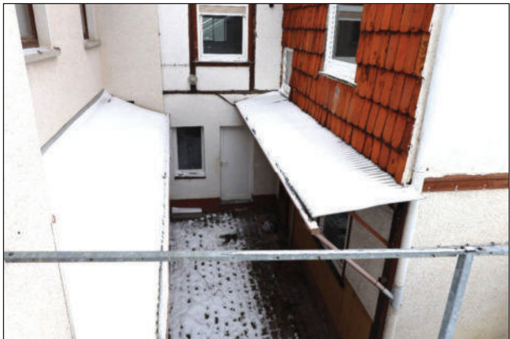
Südostansicht / Vorder- und Hinterhaus
