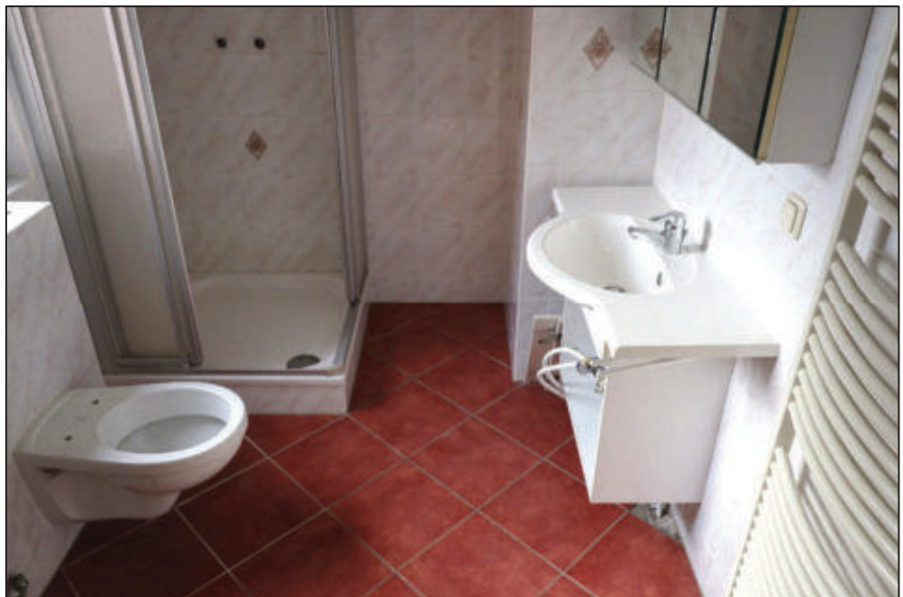
Vorderhaus – Bad WE 2 (Anbau OG)
