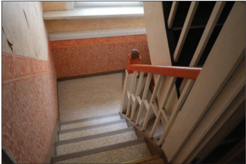
Vorderhaus – Treppe zum Obergeschoss
