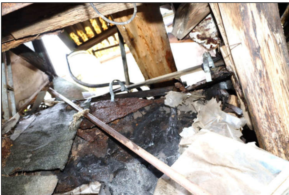
Innenansicht – Nebengebäude (Abriss)
