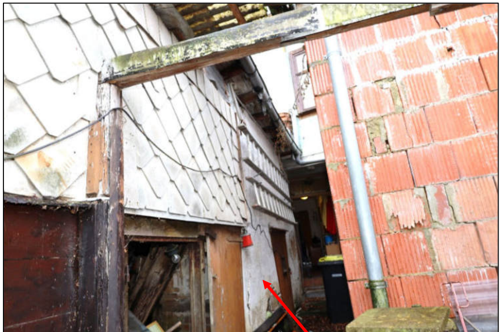
Nordostansicht – Nebengebäude (Abriss)
