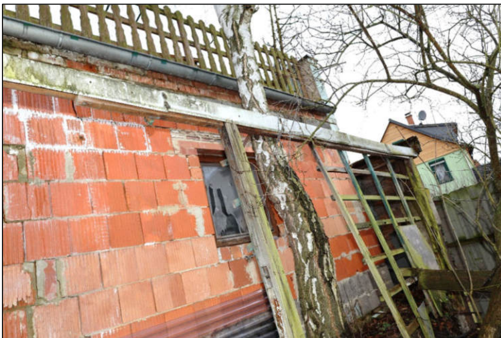
Nordostansicht Anbau EFH u. Gartenansicht
