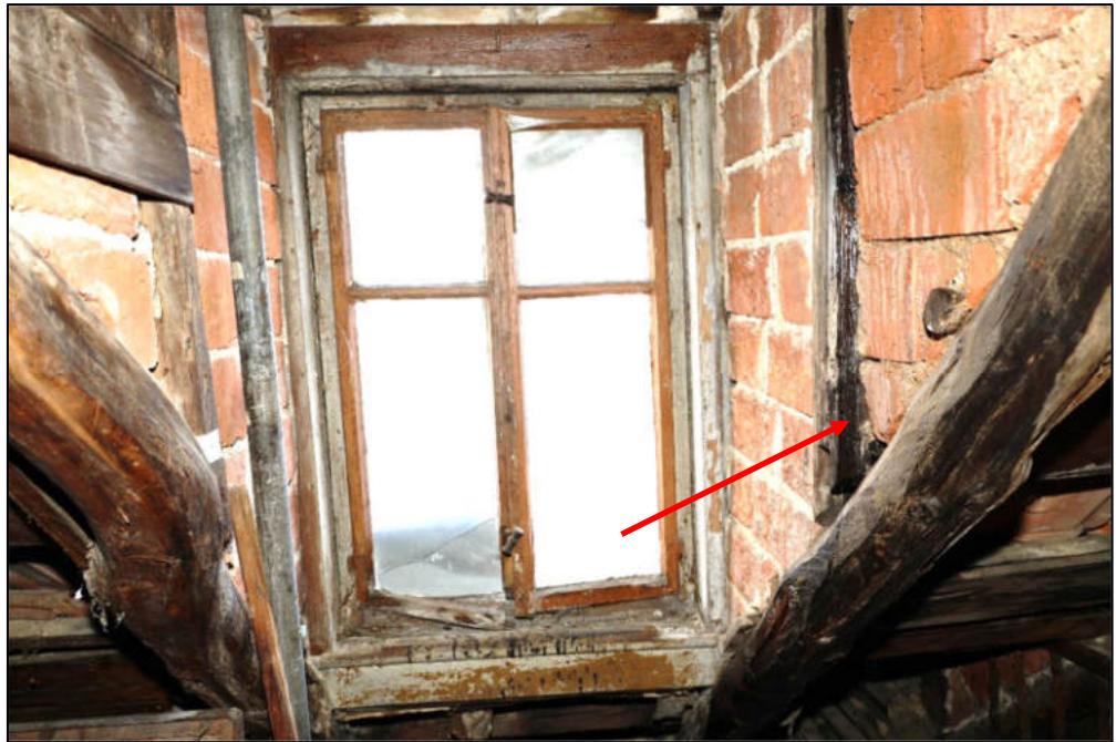
Feuchtigkeitsschäden - Dachgaube
